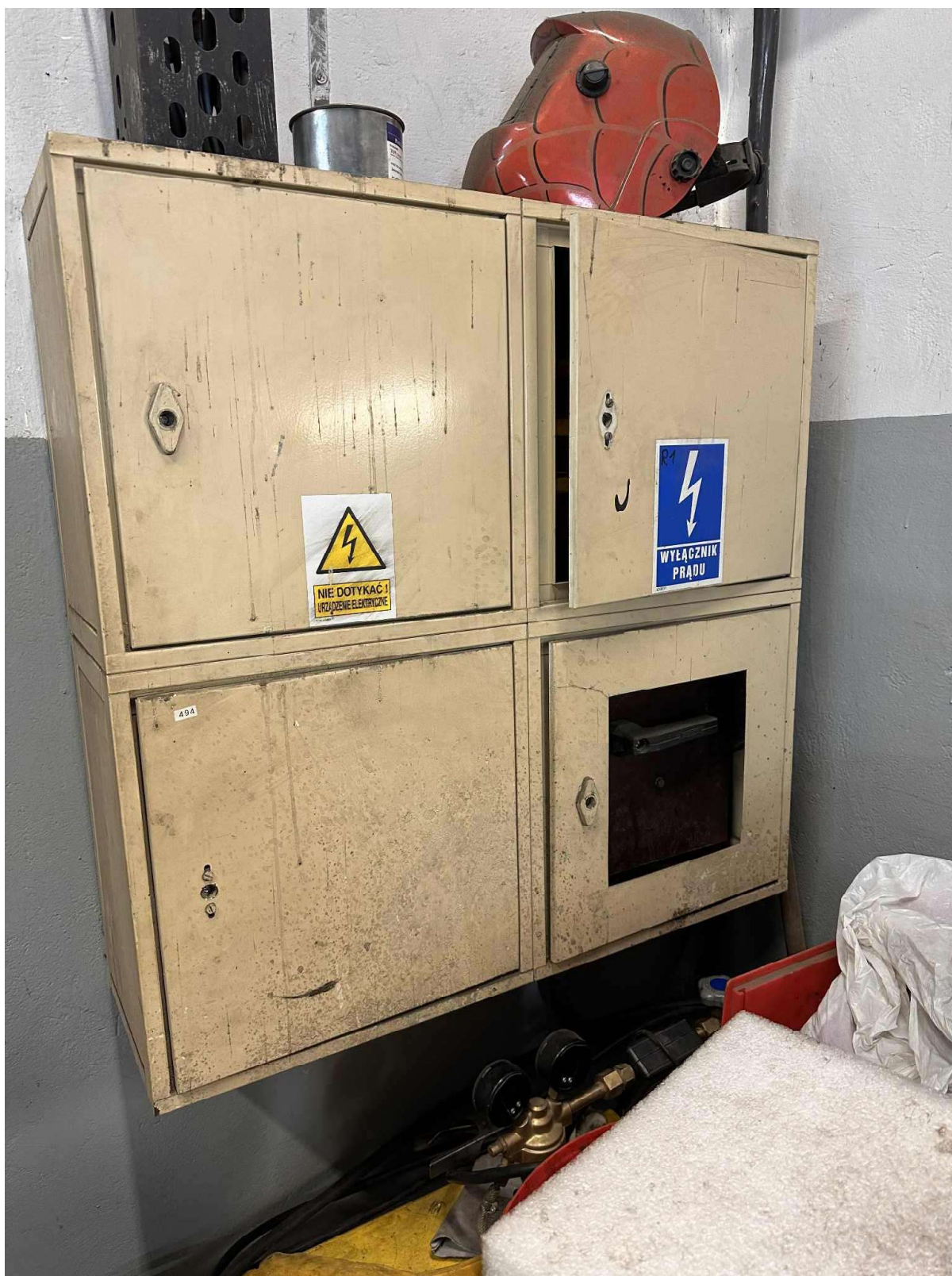
Rys. nr 13 Istniejąca rozdzielnica elektryczna – parter garaż
