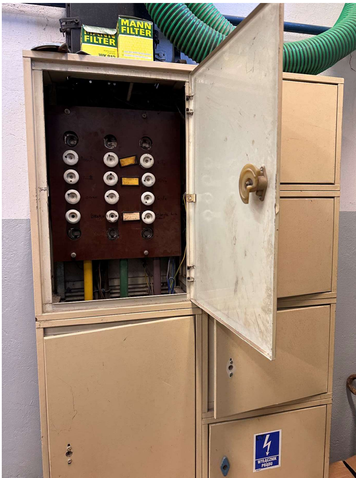
Rys. nr 11 Istniejąca rozdzielnica elektryczna – parter garaż
