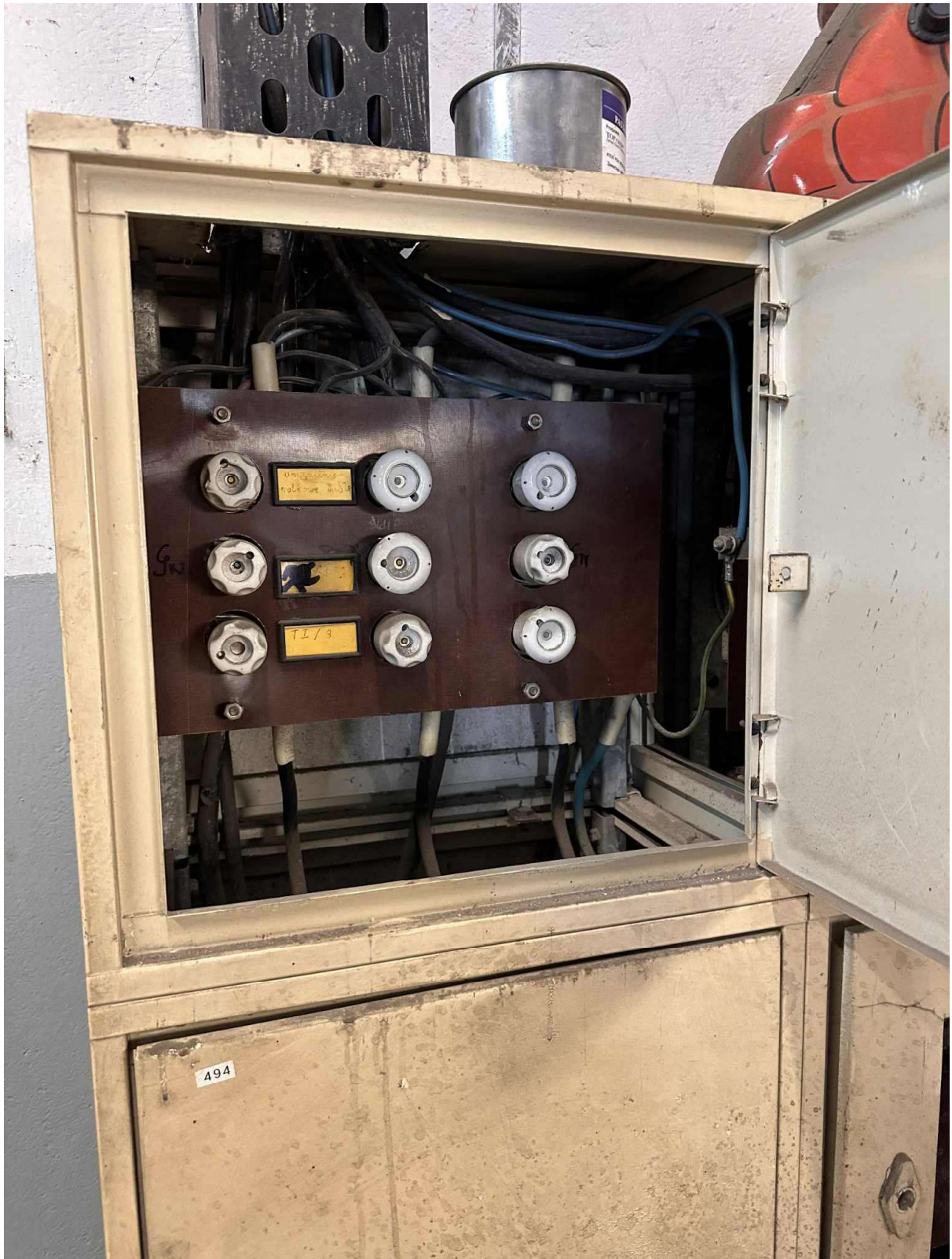
Rys. nr 15 Istniejąca rozdzielnica elektryczna – parter garaż
