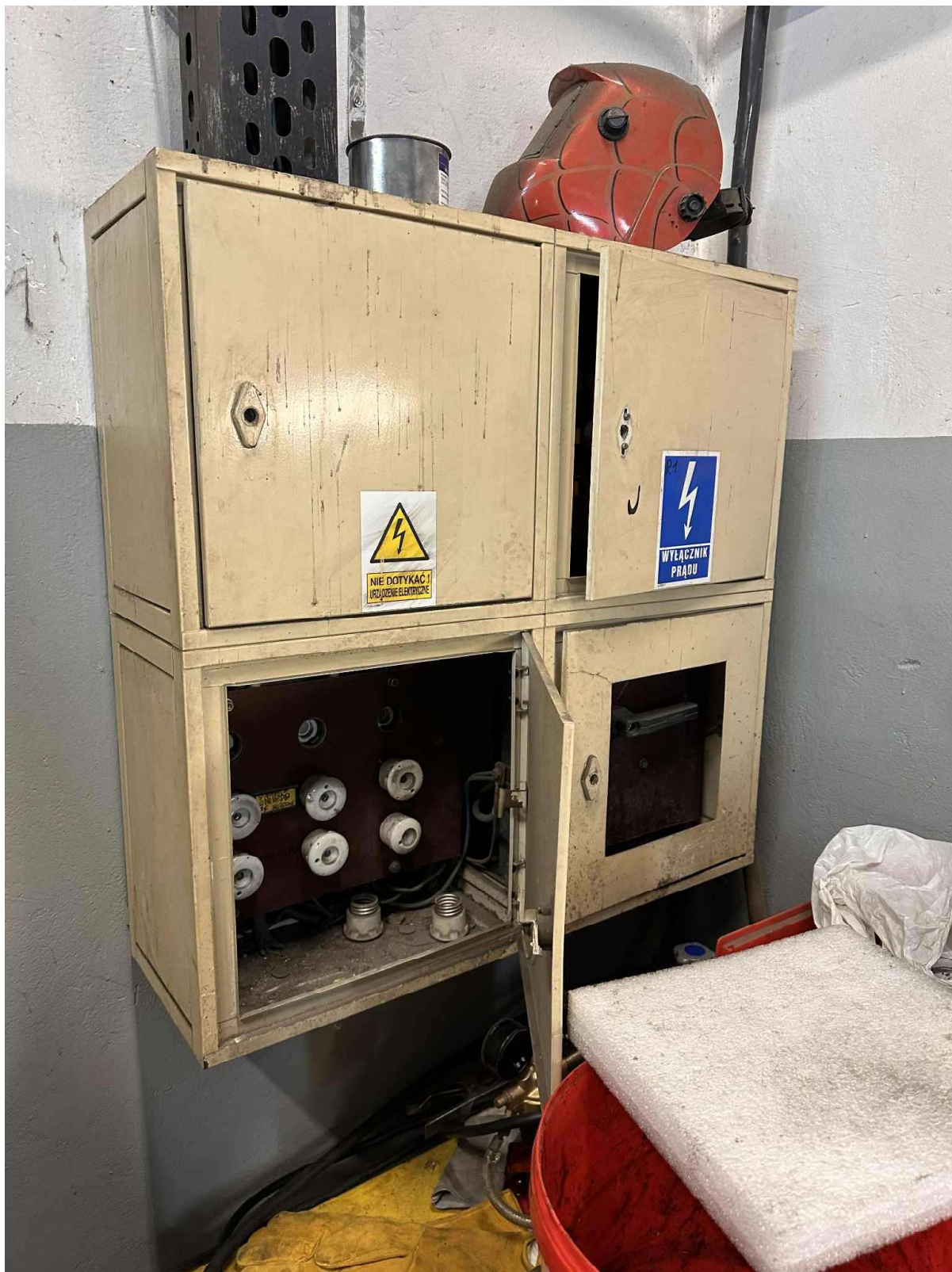
Rys. nr 14 Istniejąca rozdzielnica elektryczna – parter garaż
