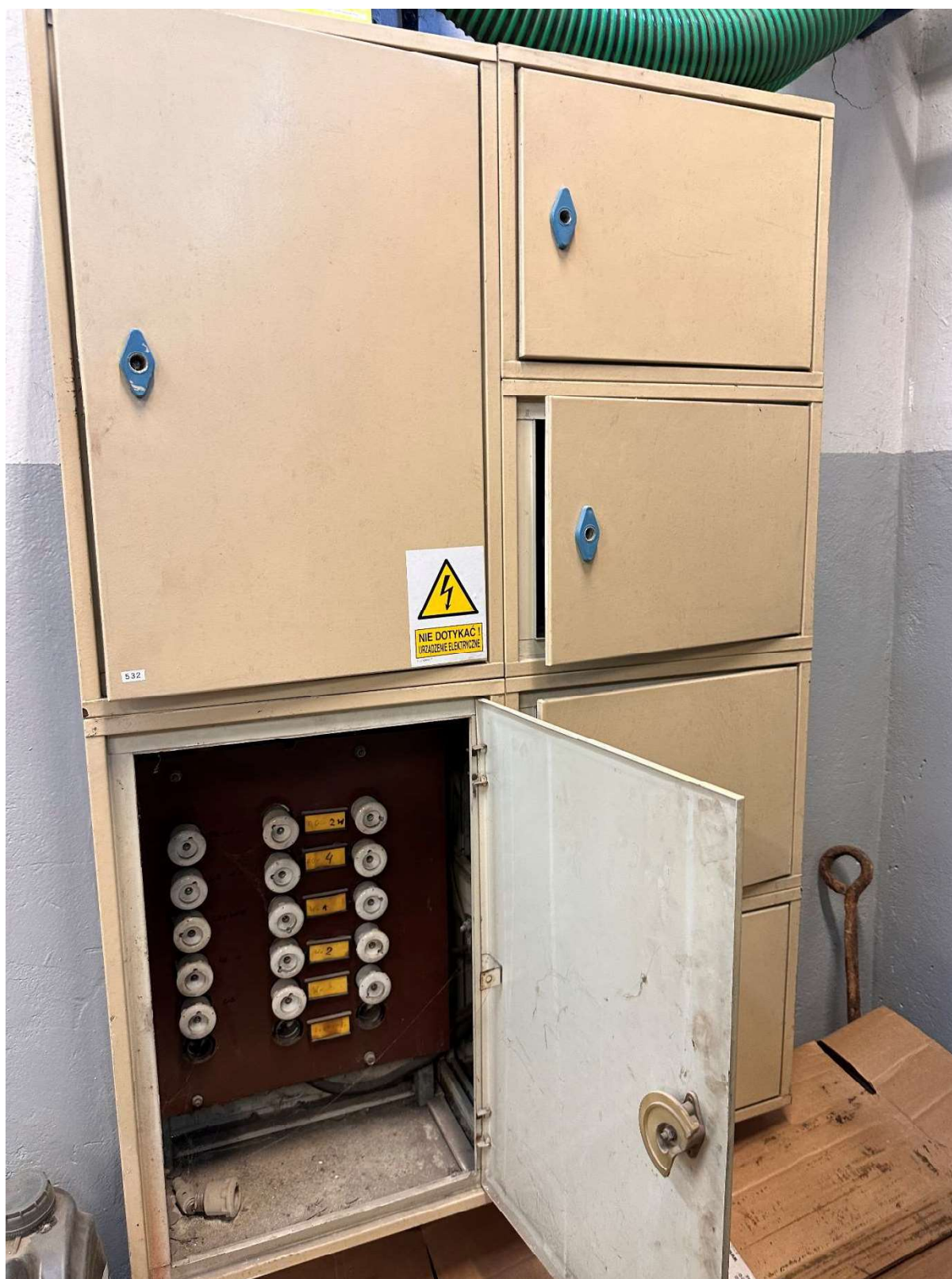
Rys. nr 10 Istniejąca rozdzielnica elektryczna – parter garaż
